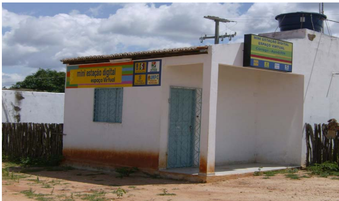
Foto 5 - Estação Digital na Comunidade do Córrego
