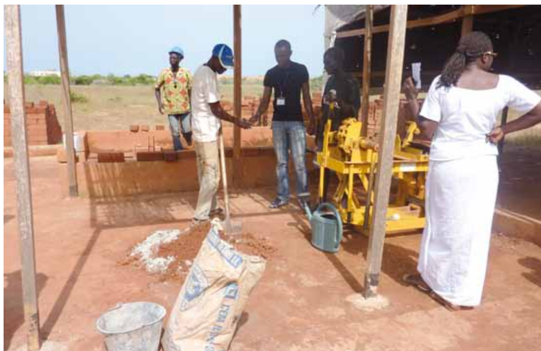
Formation à la fabrication de briques dans un village pilote, au Sénégal.
